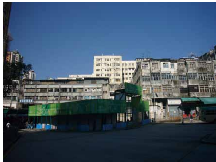
· 留待拆卸的觀塘重建區舊樓 (胡鈞翔攝，2013年)
