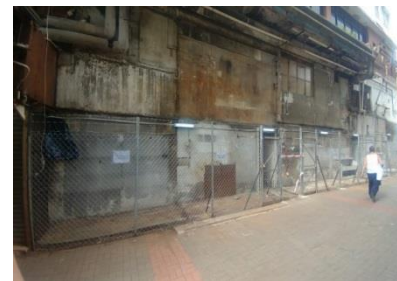
構築物拆卸及鬆脫延伸物及石屎移除後
