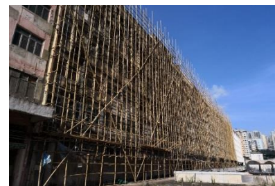
觀塘道 401-435號 工程進行中
