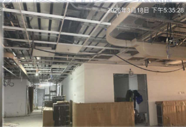
10/F 機電裝置工程
