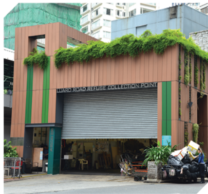
現有位於市區的垃圾收集站
