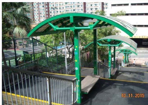
和宜合道至大隴街樓梯增建避雨亭及椅子
