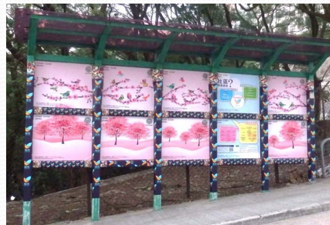
葵青區避雨亭美化工程
