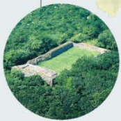
分流砲台 Fan Lau Fort
