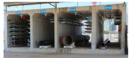
肇慶新區地下採用混凝土隧道，以鋪設各式管道、電纜等，方便維修
