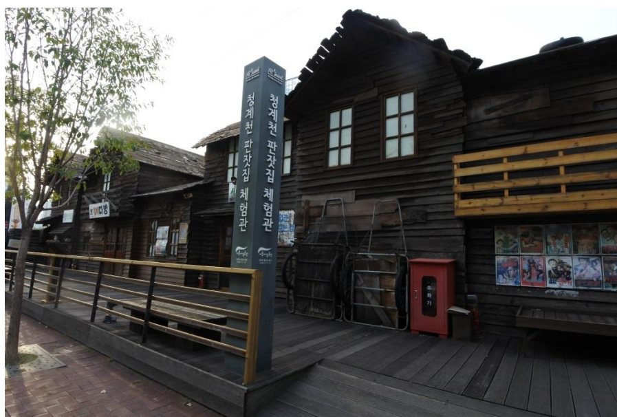
在清溪川旁，興建了模擬完成復修工程前的房屋。
