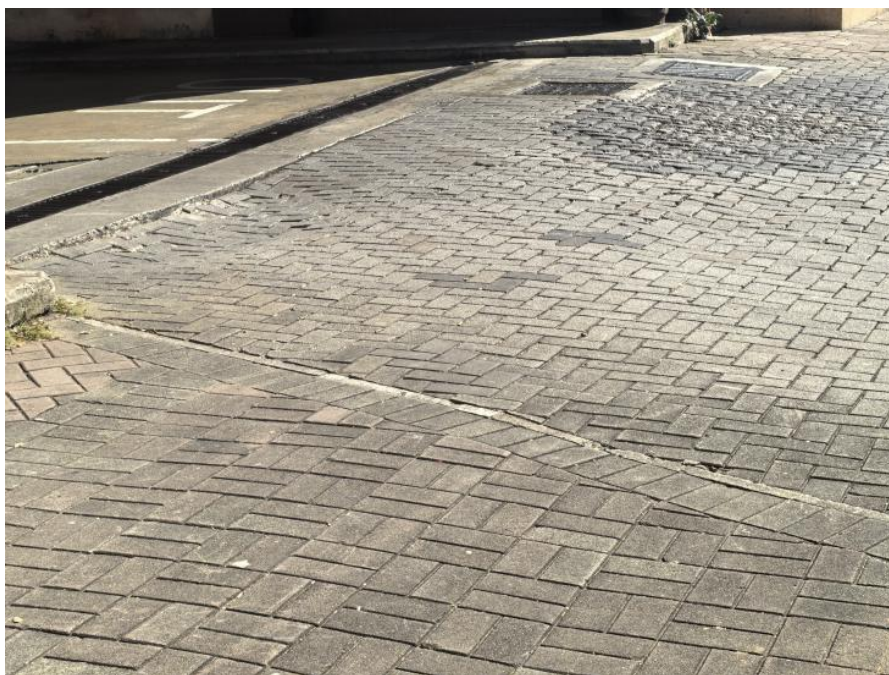
葵涌商場停車場
