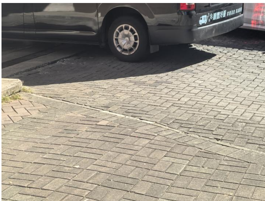
葵涌商場停車場
