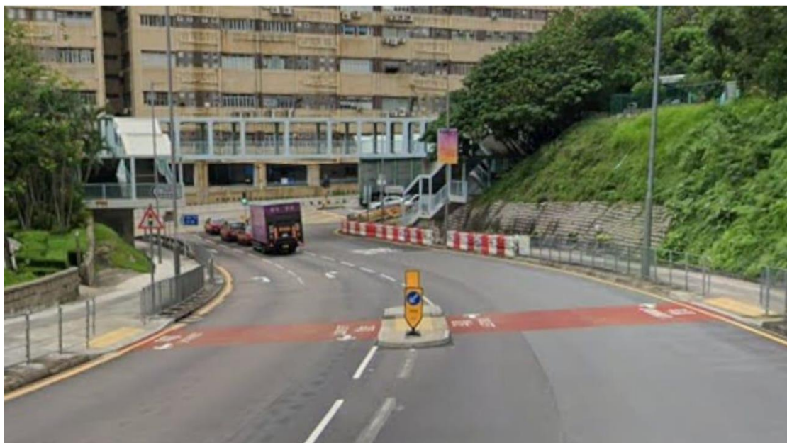
青衣涌美路青楊樓附近已髹上紅褐色行人過路處
