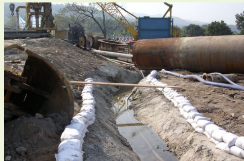
豎立沙包屏障保護排水通道
