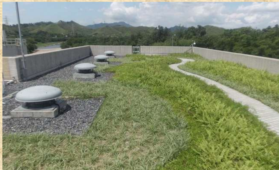
石湖墟污水處理廠天台綠化工程
