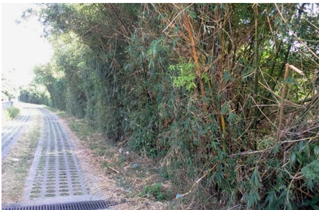
圖 64 雙魚河南岸的小路有圓形的排水坑孔 相片來源：研究團隊
