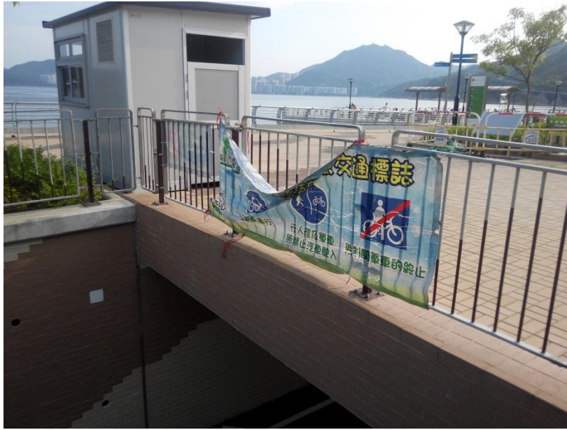
圖 1：長廊於唐俊街入口處近保安亭的單車徑隧道兩邊頂端圍欄（向日出康城方向）
