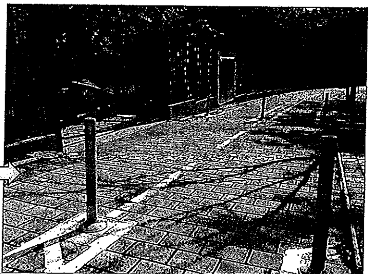
左圖中所示單車徑斜路位置的欄杆，若駕駛者收制不及撞上這些物料非常硬的欄杆，會危害生命安全。建議有關部門把欄杆物料換上黃色的防撞欄物料(右圖所示)，以減低意外發生後的受傷程度。
