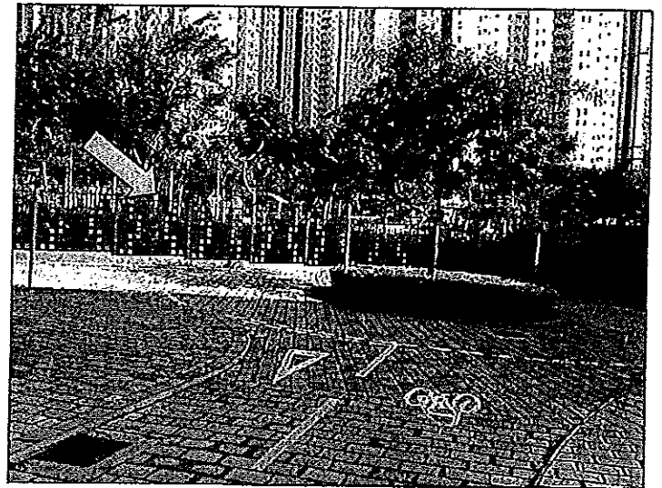
圖中顯示單車徑往迴旋處有暗轉角位(黃色箭咀所示)，令駕駛者產生盲點，加上向下斜坡位置容易加速，易生意外。
