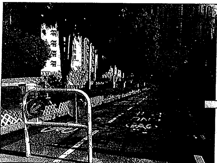
左圖中所示單車徑斜路位置的欄杆，若駕駛者收制不及撞上這些物料非常硬的欄杆，會危害生命安全。建議有關部門把欄杆物料換上黃色的防撞欄物料(右圖所示)，以減低意外發生後的受傷程度。
