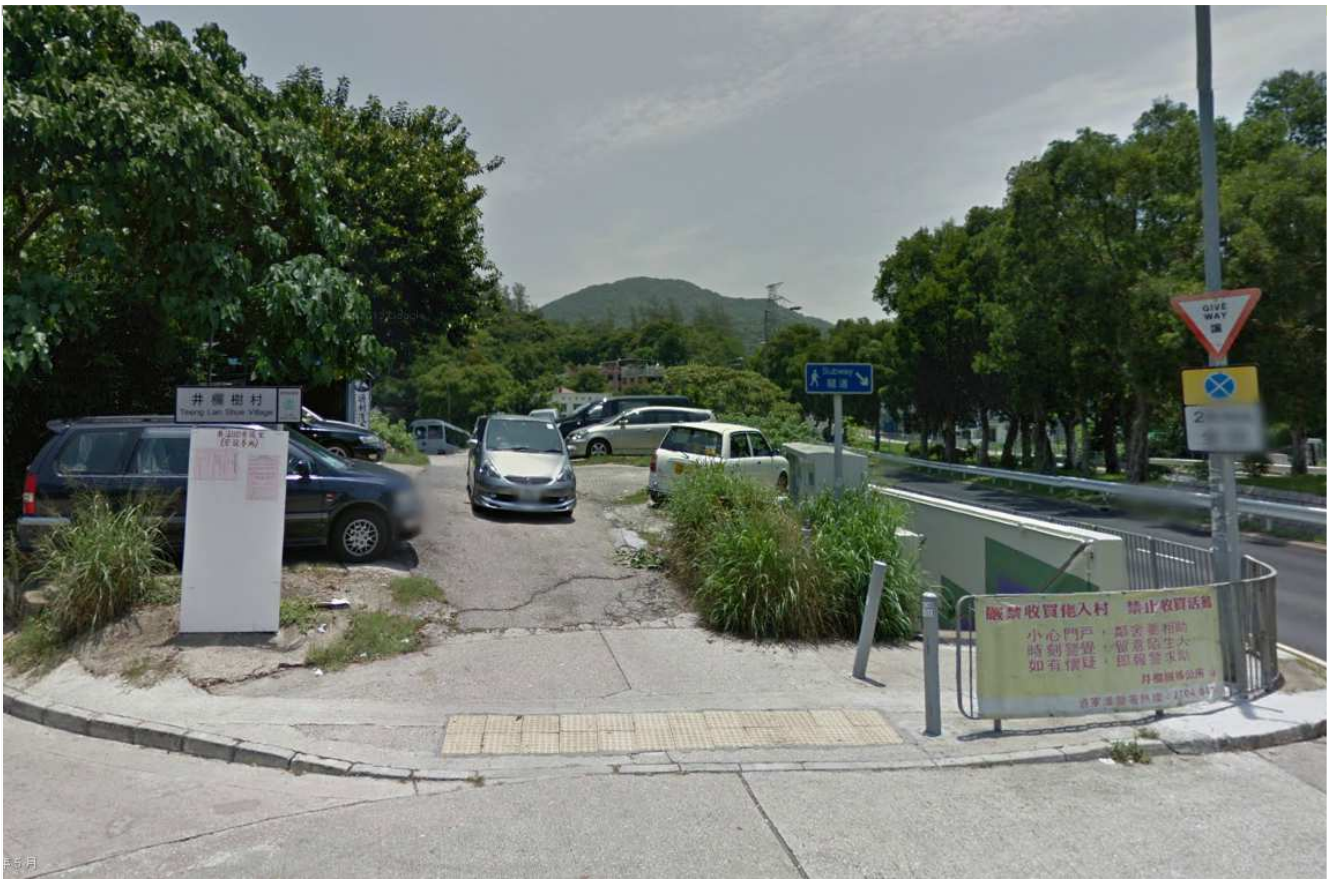
橫跨清水灣道近井欄樹的行人隧道(結構編號：NS98) 出口A的現場情況 - 附件二
