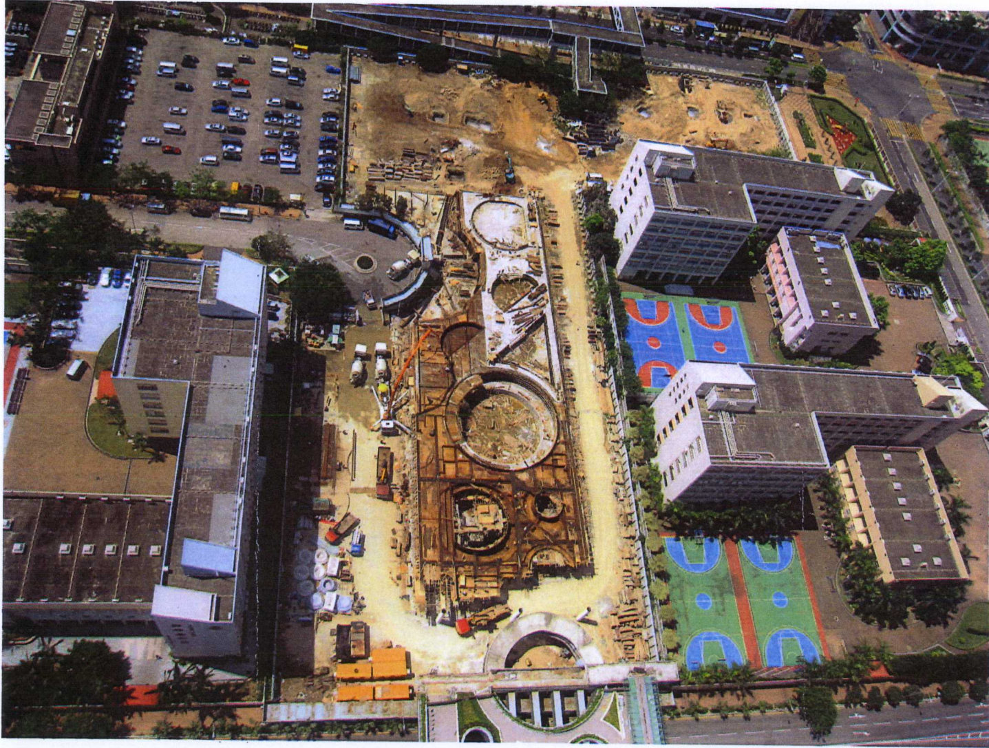
毗鄰將軍澳 56 區地區休憩用地地盤照片
