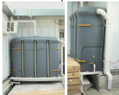
在建築物屋頂加建雨水收集系統及座地貯水缸(約10m<sup>3</sup>)，經處理後作沖廁及灌溉等用途
