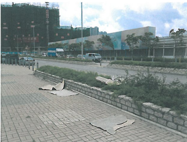
附圖三：行人路及花槽滿佈垃圾
