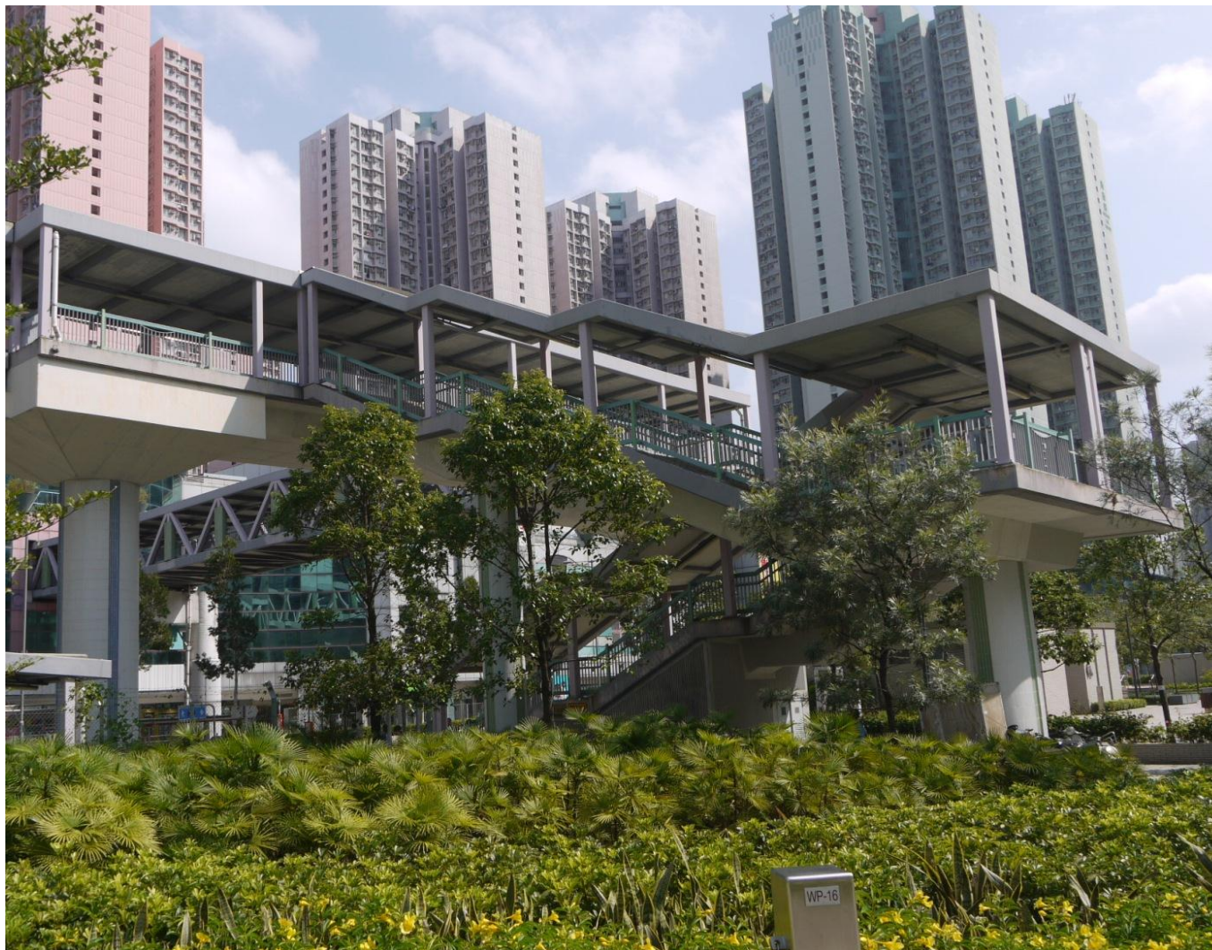
橫跨唐明街近尚德商場的行人天橋 (結構編號: NF336) A出口的現場情況
