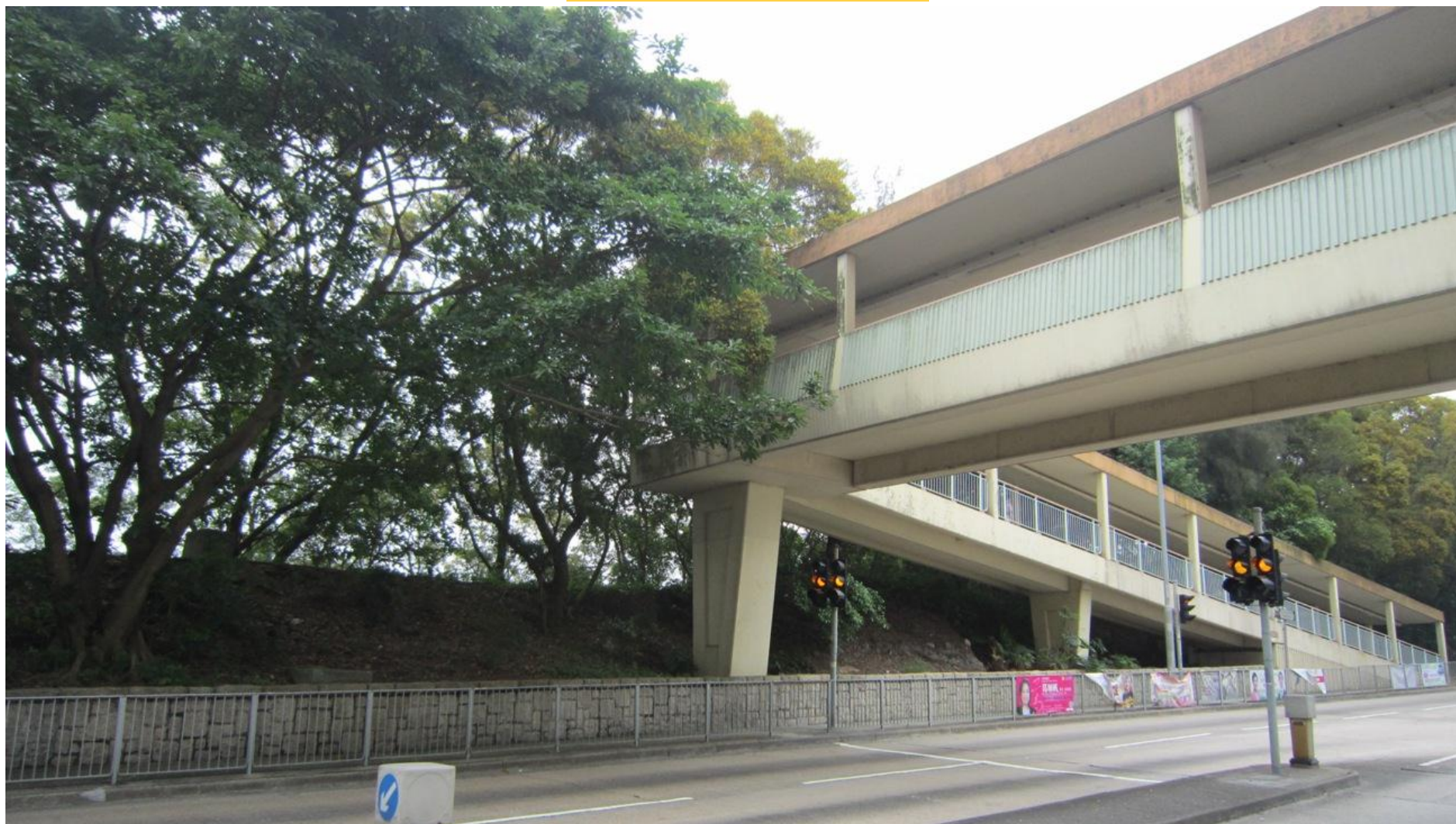
橫跨寶琳北路近林盛路的行人天橋 (結構編號: NF193) A出口的現場情況
