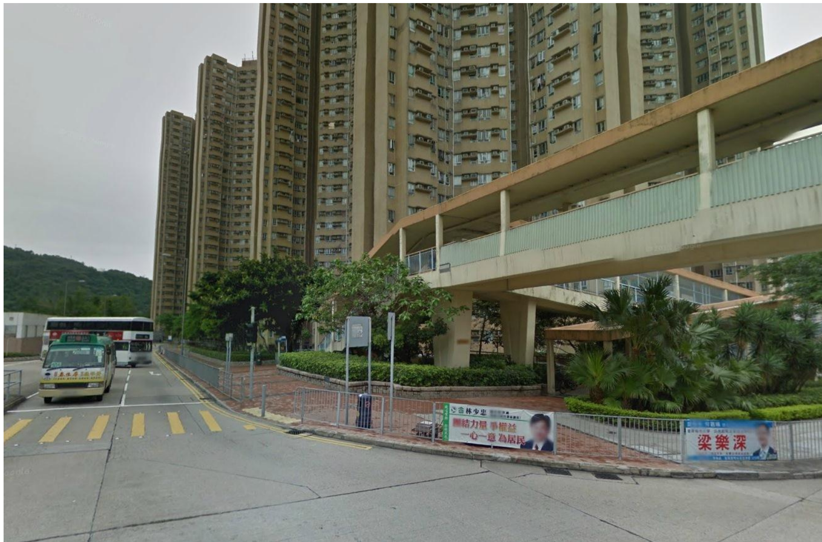
橫跨寶琳北路近林盛路的行人天橋 (結構編號: NF193) B出口的現場情況
