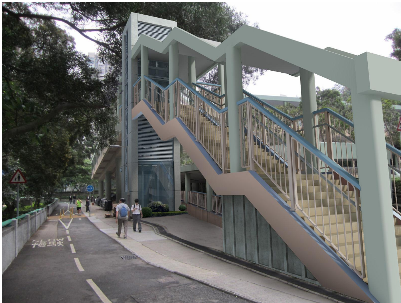
橫跨寶寧路近寶順路的行人天橋 (結構編號: NF309) B出口的擬建升降機位置
