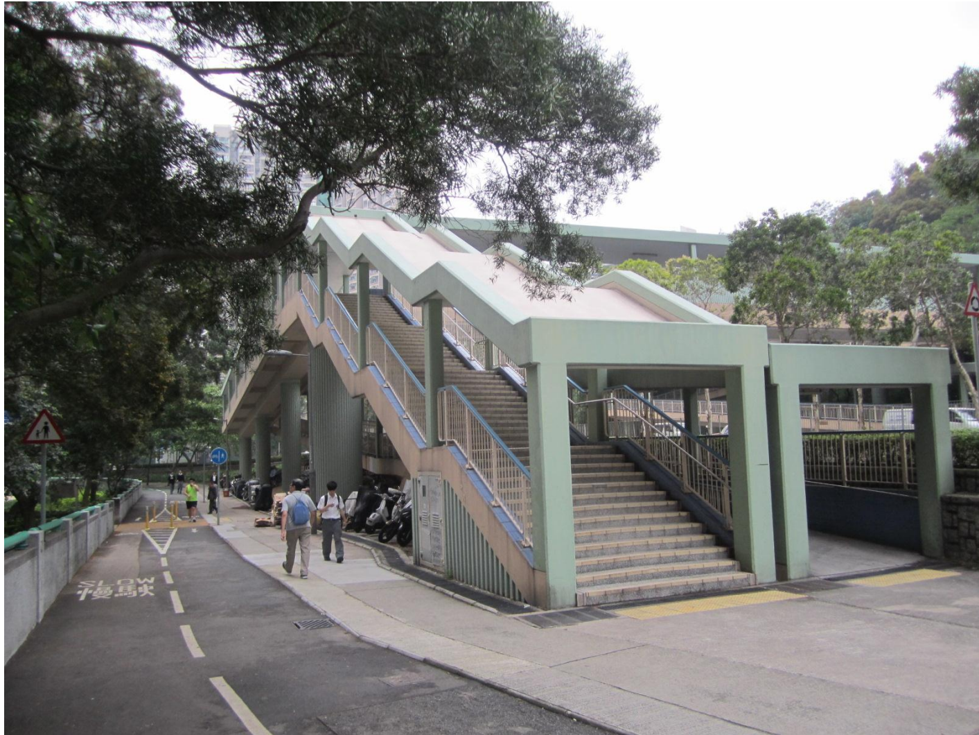
橫跨寶寧路近寶順路的行人天橋 (結構編號: NF309) B出口的現場情況
