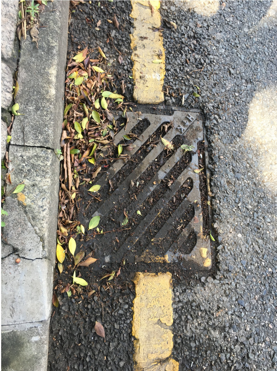
寶豐路被沙石及落葉淤塞的雨水渠
