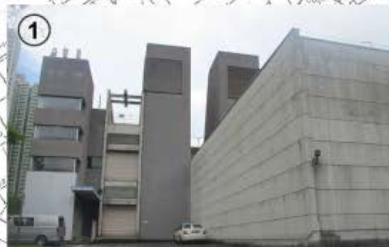
Pak Shing Kok Ventilation Building (PVB) 百勝角通風大樓
