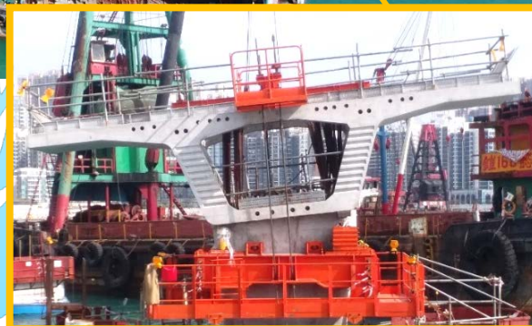
安裝海上高架橋預製組件
