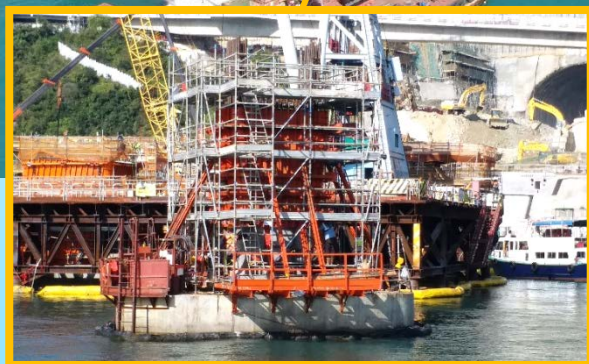
建造海上高架橋橋墩
