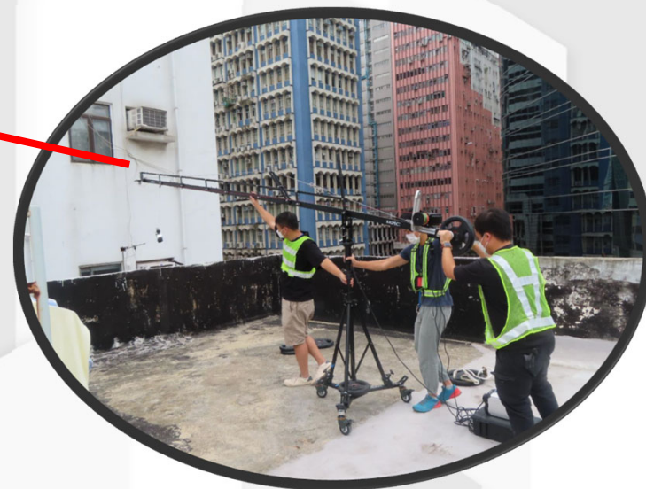
以垂吊拍攝方式進行外牆渠管檢測
