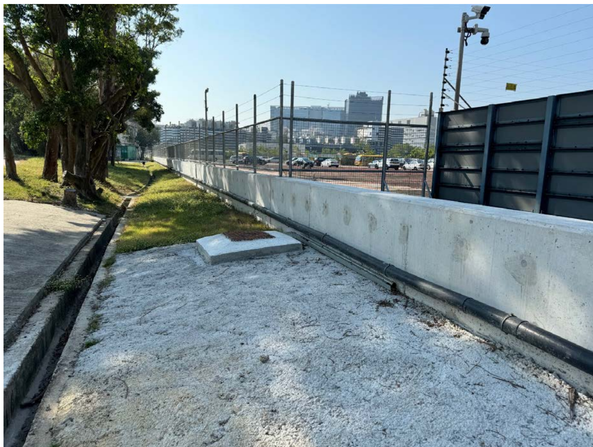
在已修復堆填區鄰近露天停車場及數據中心外圍建造的壟牆
