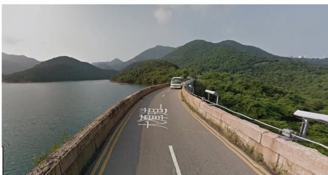
大潭道大潭篤水壩彎位，2014年8月30日的私家車撞擊事故導致部分石砌圍欄脫落，顯示圍欄無法抵擋巴士旅遊車等大型車輛撞擊。部分雙層巴士司機可能為了避免反向車輛等候，會在水壩上的彎前直路加速行駛。本人曾觀察到一部在水壩上行駛的巴士速度標板顯示60公里車速。為了控制事故風險，水壩路段的巴士旅遊車車速不宜超過35公里。
