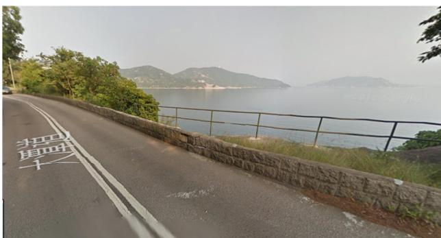
大潭道(紅山半島至赤柱)一處狹窄路面緊貼20米高海崖。石砌圍欄不具備攔阻巴士旅遊車一般速度撞擊的能力。
