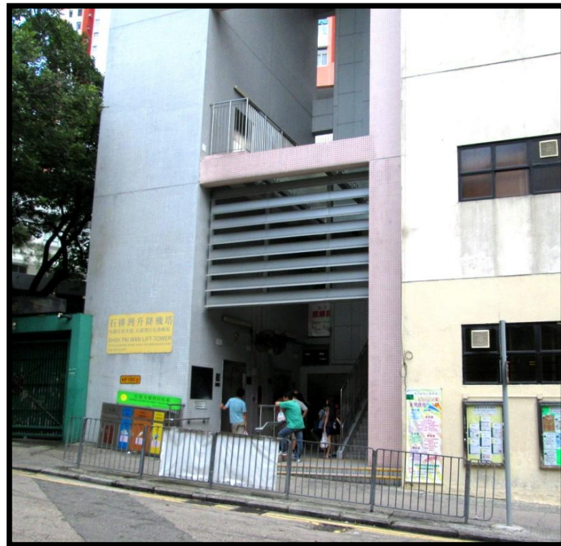
石排灣邨升降機塔出入口 (漁暉道)安裝簷蓬工程
