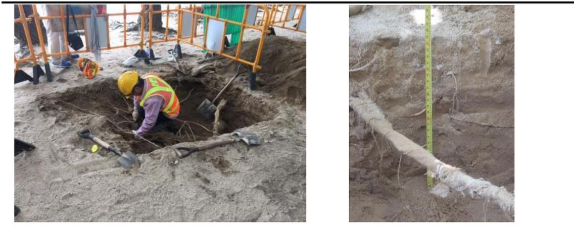
圖 3 外露的樹根系統及以麻布包裹的情況。探井側面展示了 0.5 米以下的泳灘土層，包括卵石／小石。
