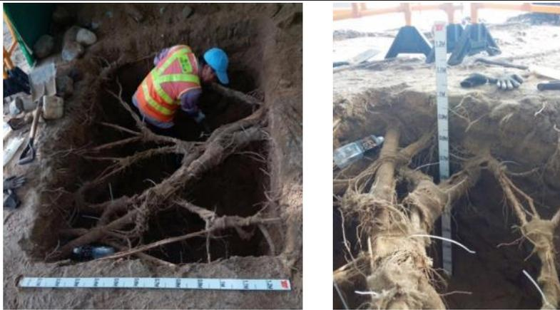
圖 5 以現有被掘出的沙和卵石／小石回填至探井內，並把沙灘回復至施工前的狀態。
