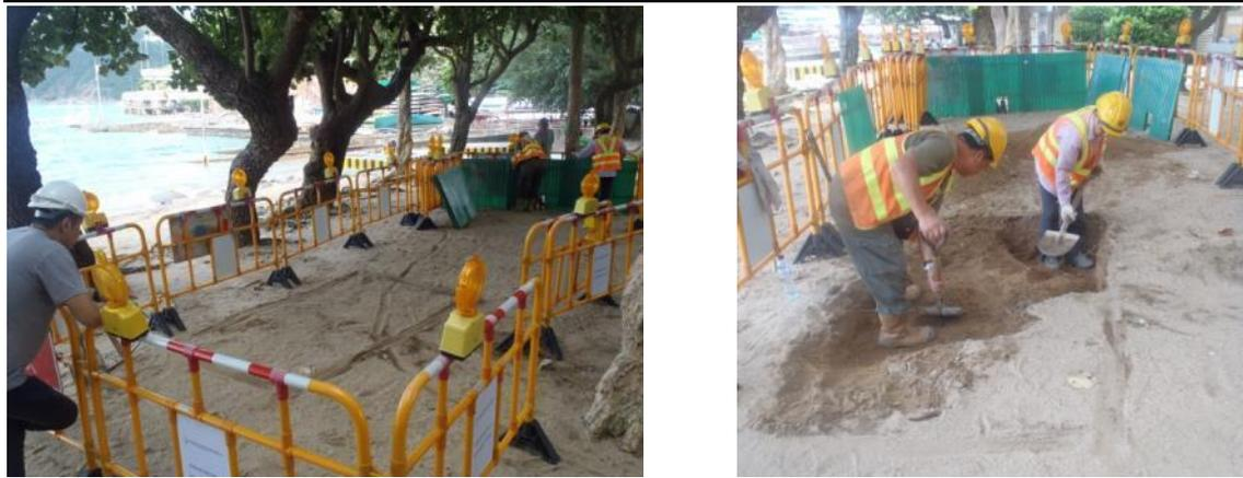
**圖 2** 以手動工具小心挖掘後，約於 0.3-0.5 米深處露出樹根系統
