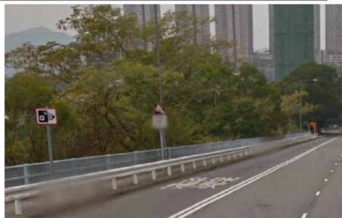
偵速攝影機及警告指示牌的位置
