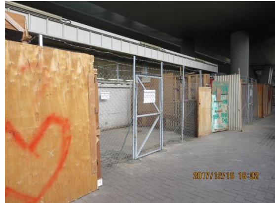
拆除及清潔行動後
