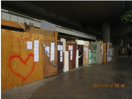
拆除及清潔行動前
