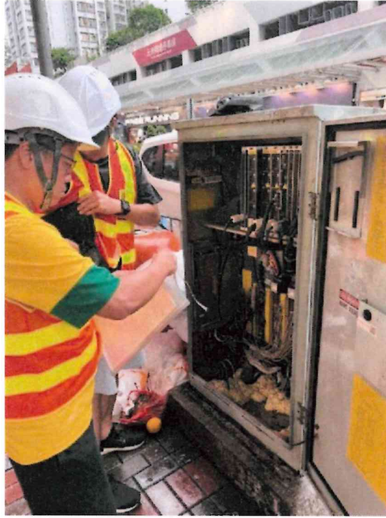
圖一 機電工程署維修團隊在 2023 年 9 月 1 日 到元州街及興華街十字路口檢查交通控制器
