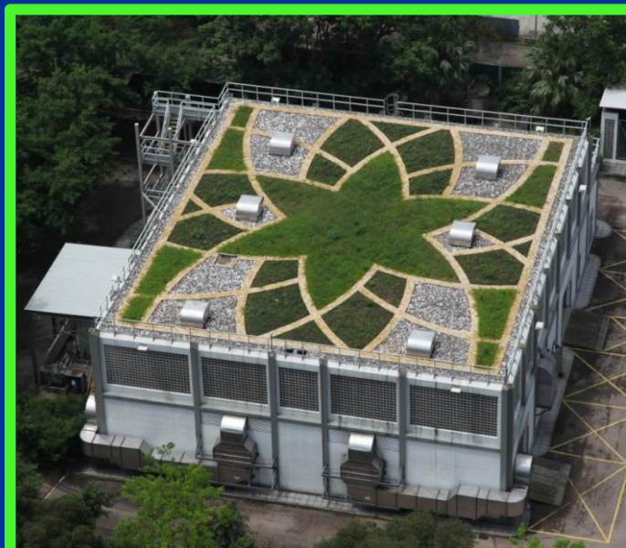
馬鞍山污水泵房綠化天臺
