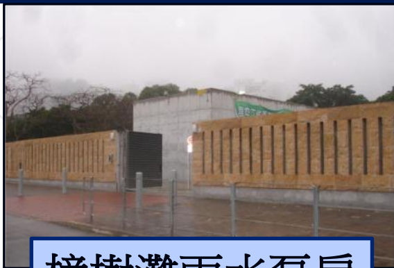
樟樹灘雨水泵房
