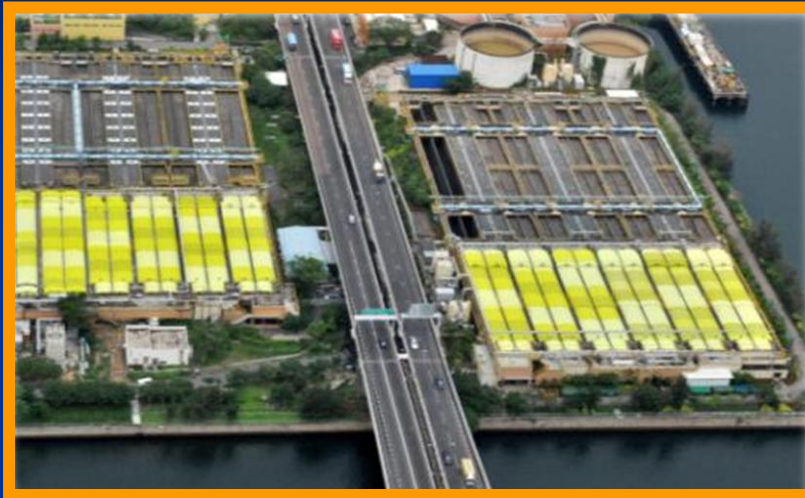
沙田污水處理廠 覆蓋沉澱池工程
