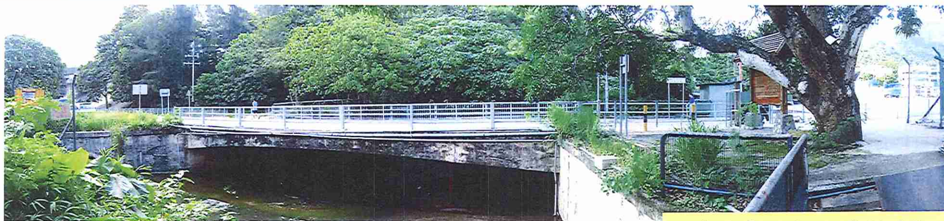
原有橫跨明渠的單車橋外觀
