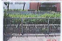
欄杆型單車泊架
