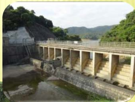
九龍水塘溢洪壩
