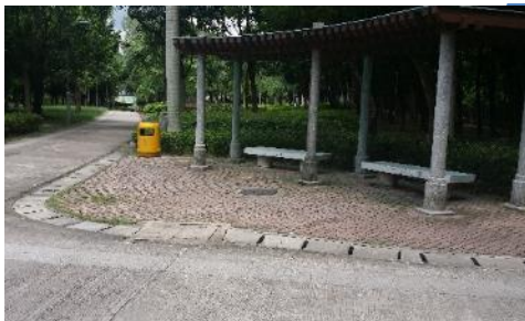
照片7：更換混凝土渠蓋
