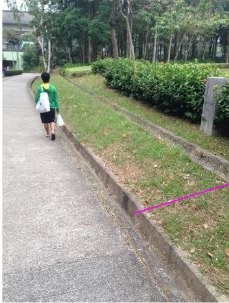
照片6 :新鋪混凝土渠蓋
