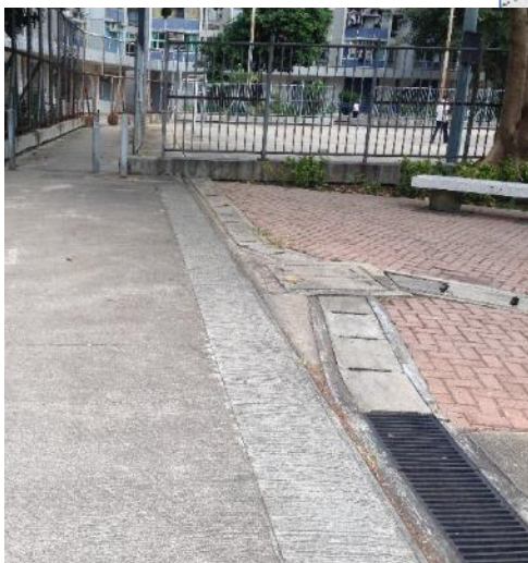
照片8：更換混凝土渠蓋
