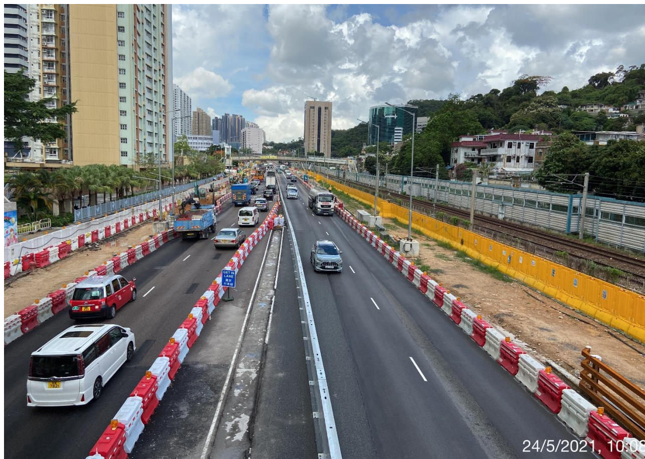
施工中的大埔公路(沙田段)擴闊工程
