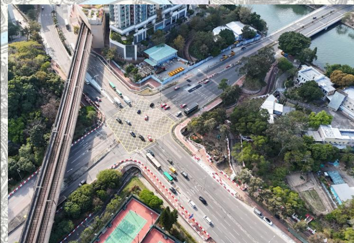
大涌橋路十字路口 移除樹木及污水渠改道工程
