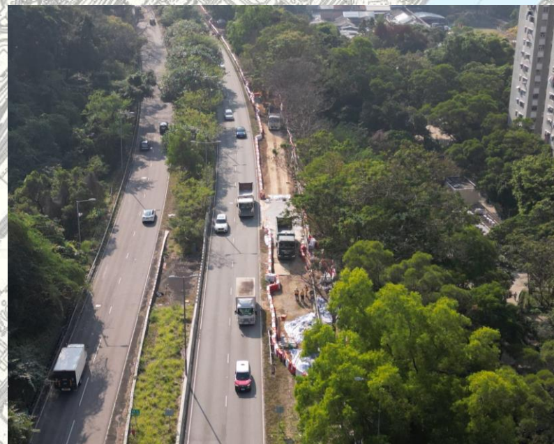
沿沙田路(東行)近博康邨進行工地平整
