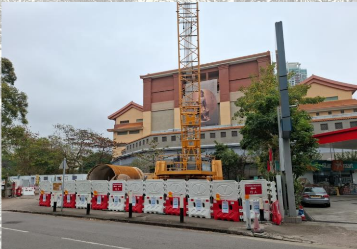
近香港文化博物館工地開展鑽孔樁工程
