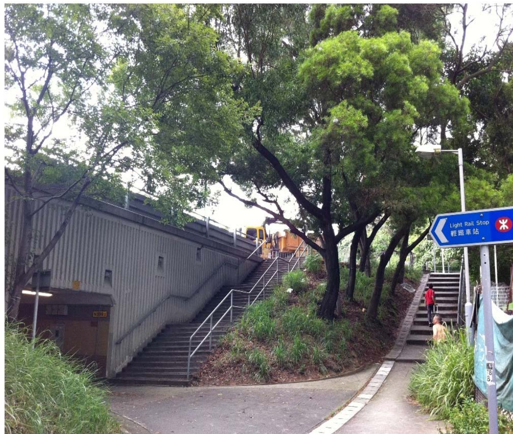
現有行人隧道 'B' 出口
