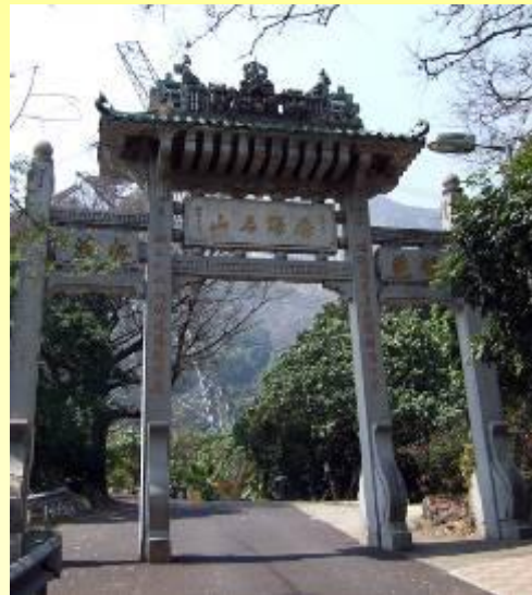
青山禪院牌樓(香海名山) (一級歷史建築)
