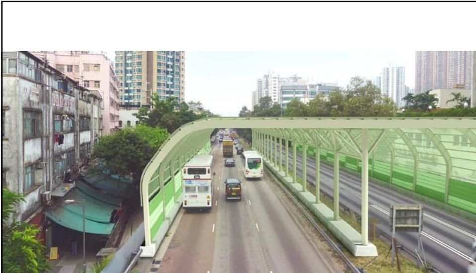
密閉式隔音罩(電腦模擬圖片)
