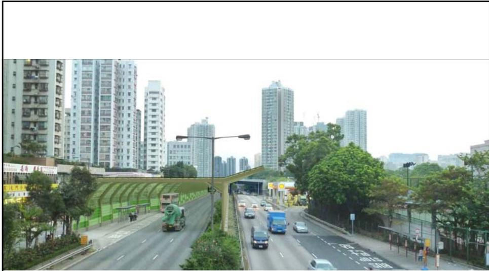
半密閉式隔音罩(電腦模擬圖片)
