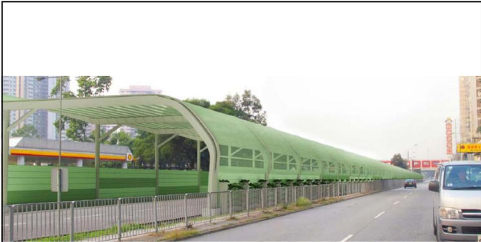
半密閉式隔音罩(電腦模擬圖片)
