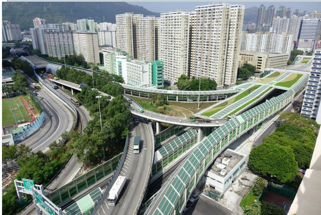
屯門公路隔音屏障 (主題相片)
