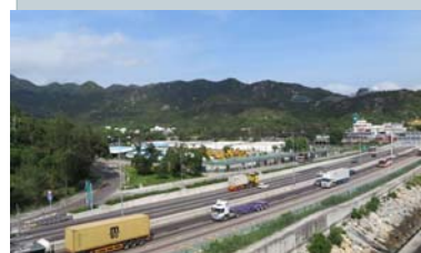
屯門公路重建及改善工程完成後的面貌 (主題相片)
