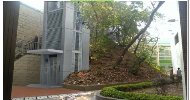
橫過屯興路近屯門公路的行人隧道 (結構編號: NS42) A出口的擬建升降機位置
