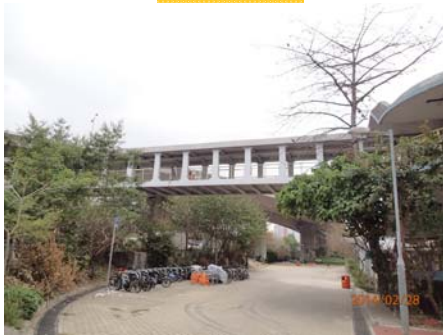
橫跨龍門路近龍門輕鐵站的行人天橋 (結構編號: NF315) A出口的現場情況
