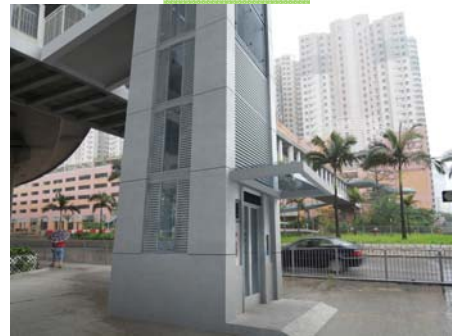
橫跨龍門路近龍門輕鐵站的行人天橋 (結構編號: NF315) B出口的擬建升降機位置
