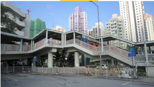
橫跨屯門公路連接青杏徑及新和里的行人天橋 (結構編號: NF174) B出口的現場情況
