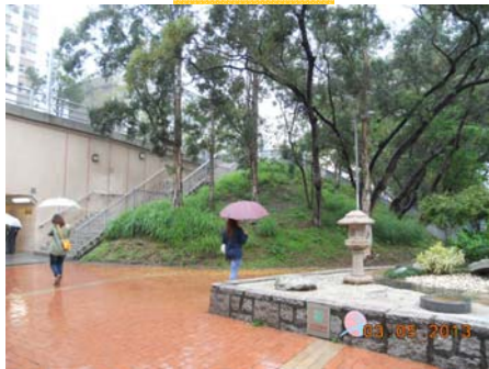
橫過屯興路近屯門公路的行人隧道 (結構編號: NS42) B出口的現場情況
