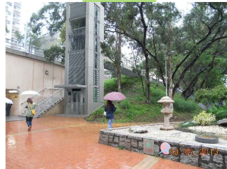
橫過屯興路近屯門公路的行人隧道 (結構編號: NS42) B出口的擬建升降機位置
