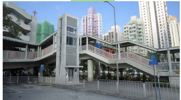
橫跨屯門公路連接青杏徑及新和里的行人天橋 (結構編號: NF174) B出口的擬建升降機位置
