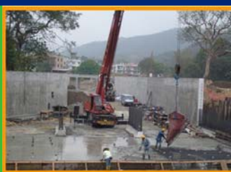
施工中的掃管笏排水道
