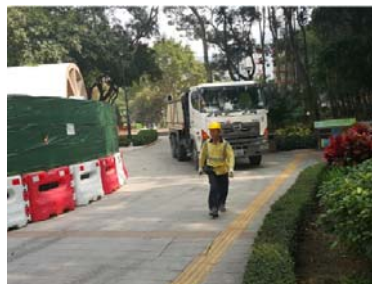
工程車輛由交通導員帶領進出工地
