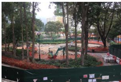
北面兒童遊樂場 - 清拆工程進行中
