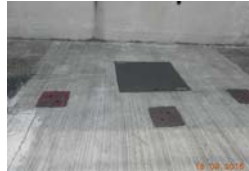
沙井完成後的路面情況
