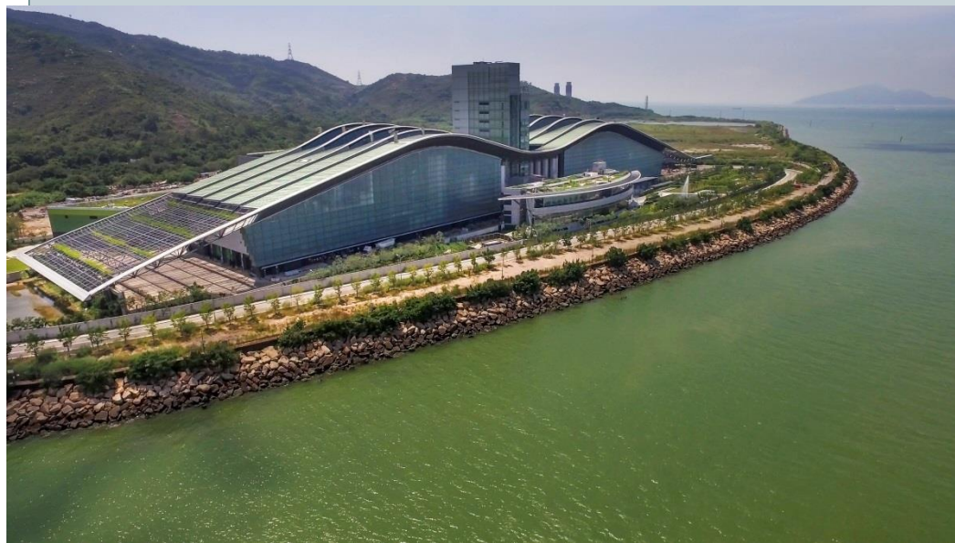
污泥處理設施外觀 (主題相片)
