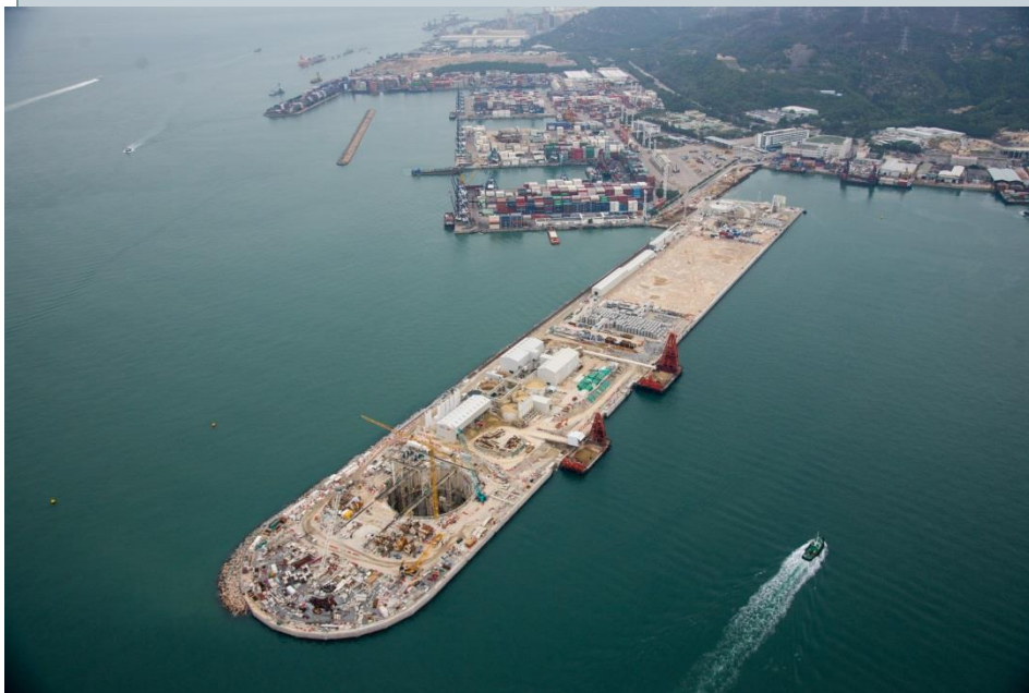
北面連接路海底隧道段的北面出入口填海區 (主題相片)
