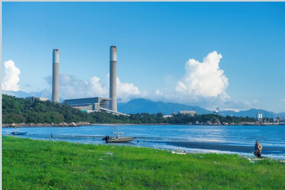
青山灘發電廠 (主題相片)
