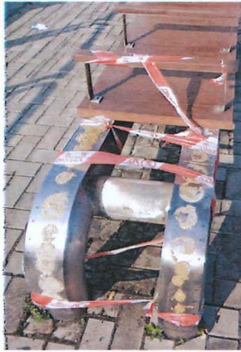
圖 H：座椅風擋木板剝落
